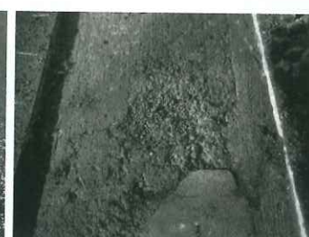
開削後(土砂化確認)
