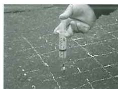
②特殊カラー樹脂注入
