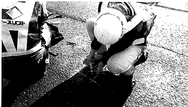
写真-4 特殊カラー樹脂の注入
